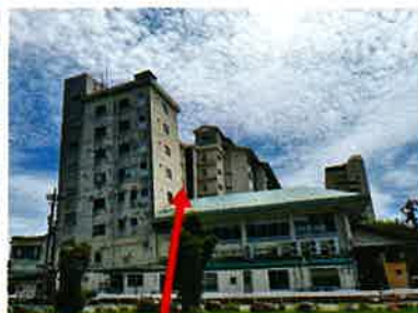
割れて倒れかけているホテル
